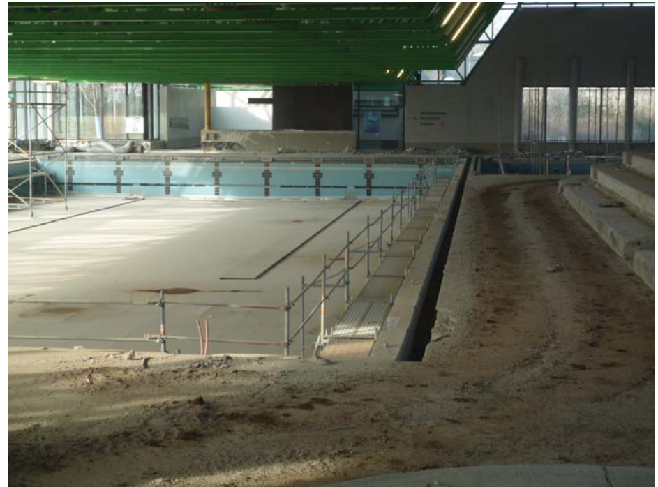
Bauarbeiten im Westbad
